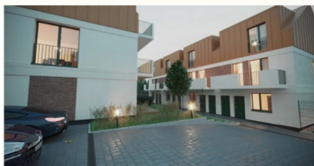
Widok pomiędzy budynkami
