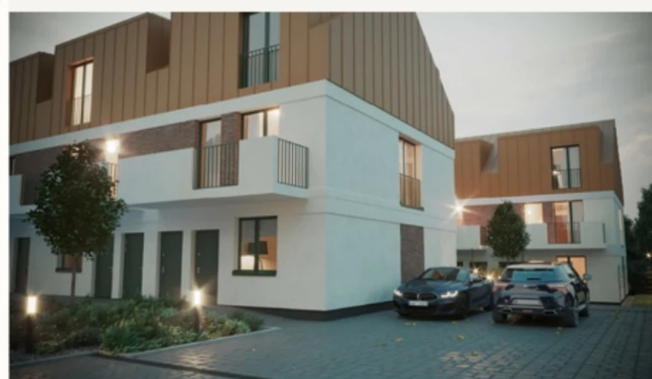
Elewacje i wejścia
